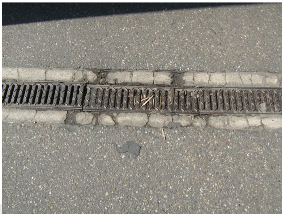
Foto: Aansluiting op lijngoot.
